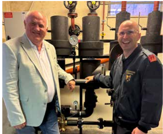
BGM Ernst Wendl und Feuerwehrkommandant Wolfgang Ernst in der neuen Fernwärmeübergabestation der Feuerwehr Himberg
