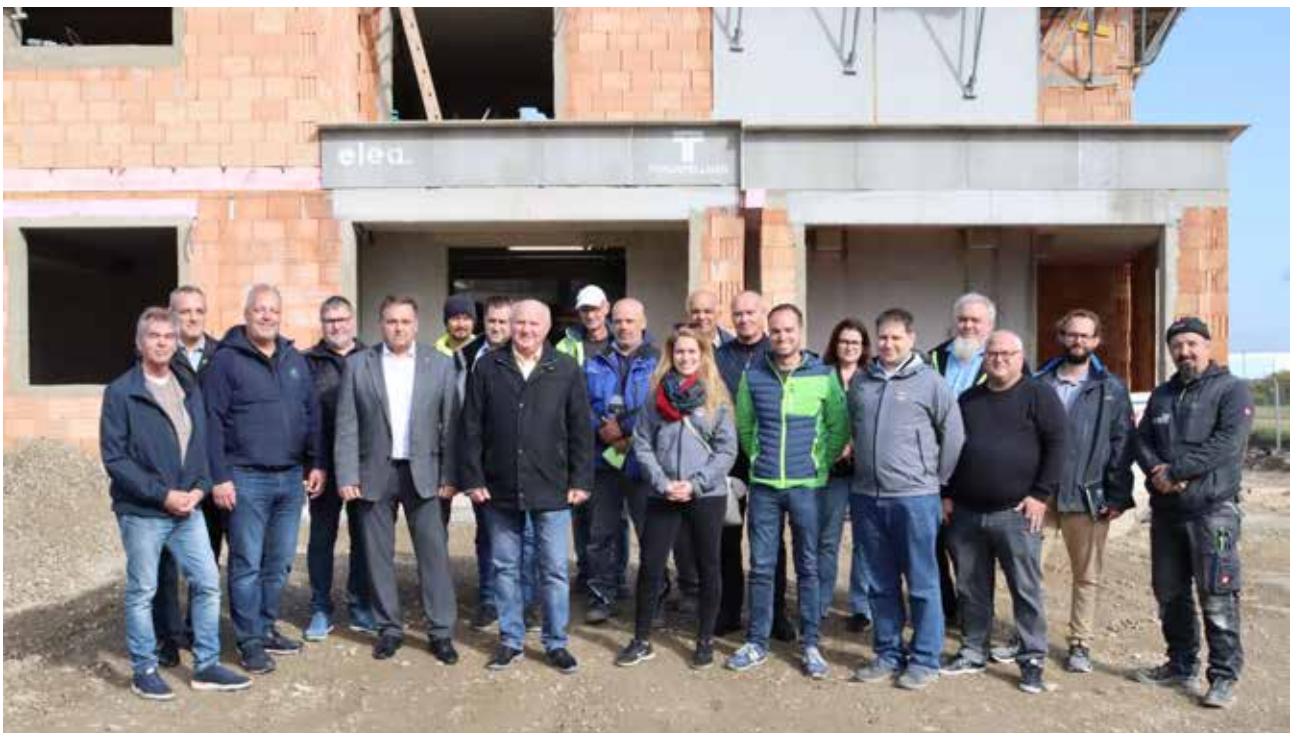
Meilenstein: Dachgleiche neuer Kindergarten Wienerstraße
