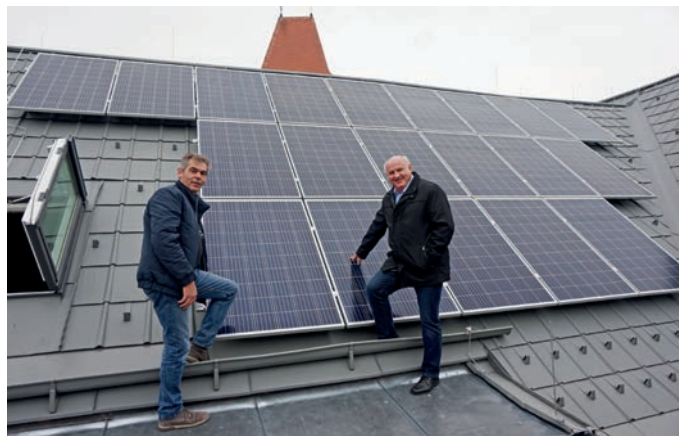
Neue Photovoltaikanlagen sorgen für umweltfreundlichen Strom in der Gemeinde
