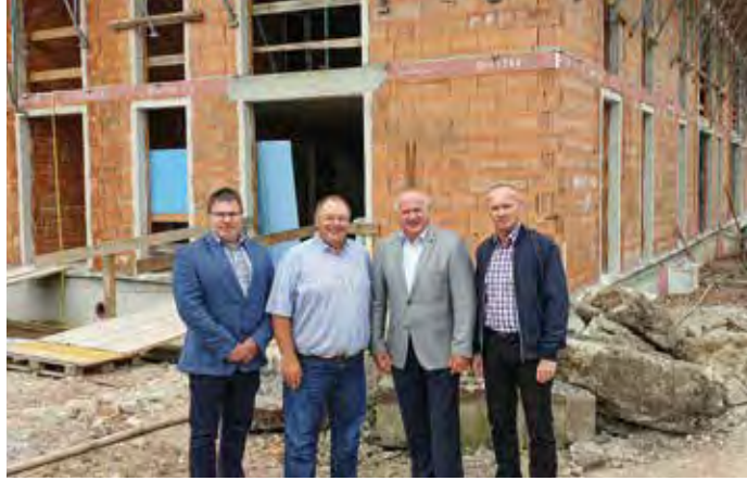
GGR Josef Auer, Obmann KommR. Andreas Holzmann, BGM Ernst Wendl, Bauamtsleiter Robert Ruzak beim Rohbau Velmerstrasse 10
