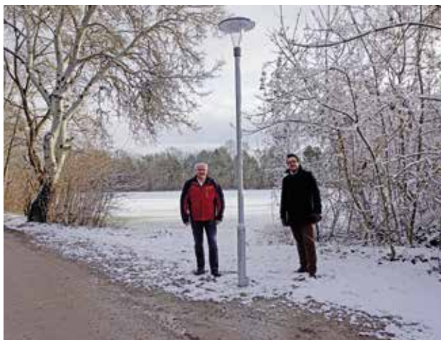
BGM Ernst Wendl und Vizebgm. Richard Payer bei der neuen Beleuchtung
