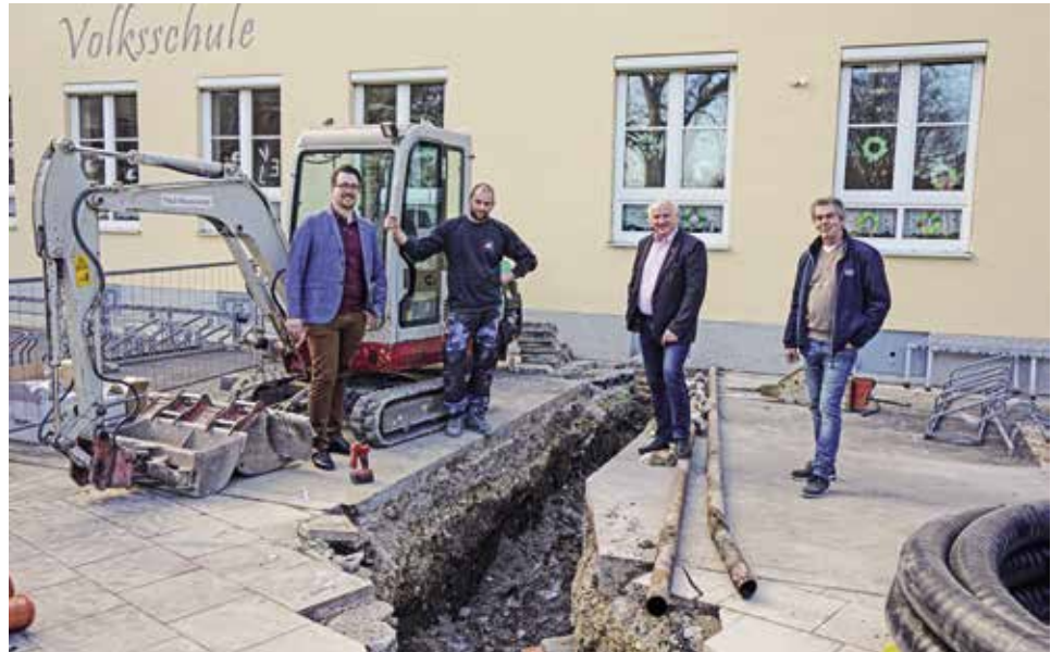
Vizebgm. Richard Payer, Installateurmeister Alfred Enzminger, BGM Ernst Wendl und GGR Herbert Stuxer beim Ortsaugenschein auf der Baustelle
